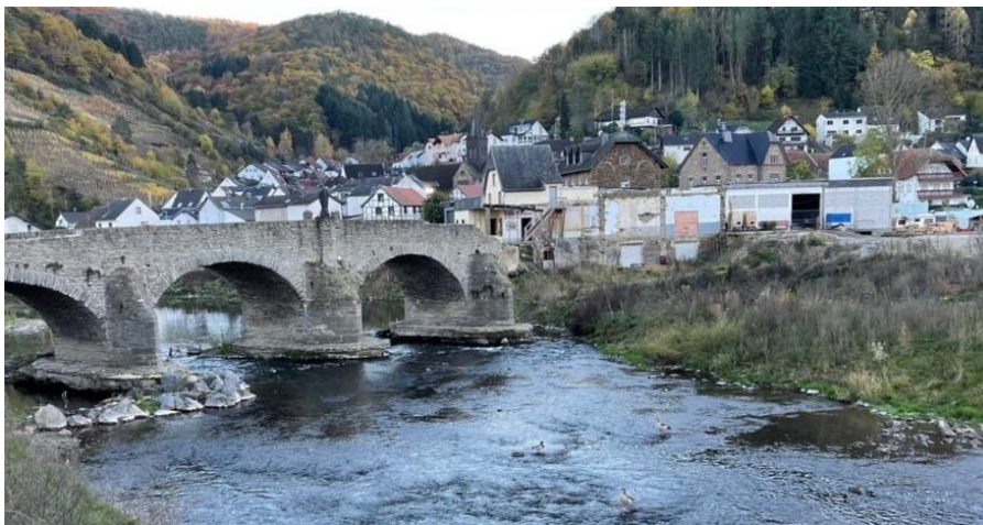
Ahrbrücke Rech nach der Zerstörung
